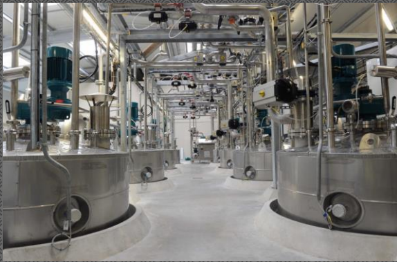
Cuve matière automatisée
