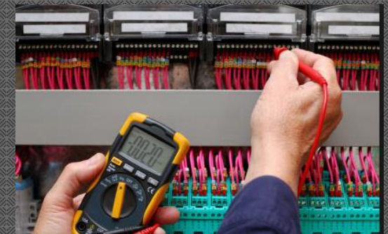
Vérification par multimétrie
